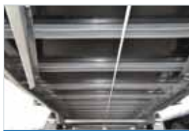
Masivní konstrukce rámu
